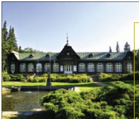
LÁZEŇSKÝ AREÁL V KARLOVĚ STUDÁNCE
